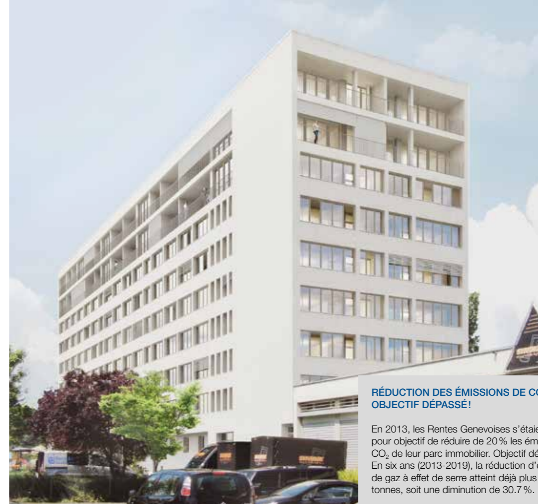
La rénovation de l'immeuble de la rue des Bossons, construit en 1960, intégrera parfaitement les deux nouveaux étages.
