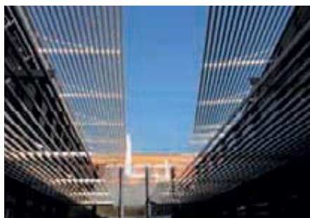
3 – Feststehender Sonnenschutz mit Aluminiumlamellen, auskragend.
