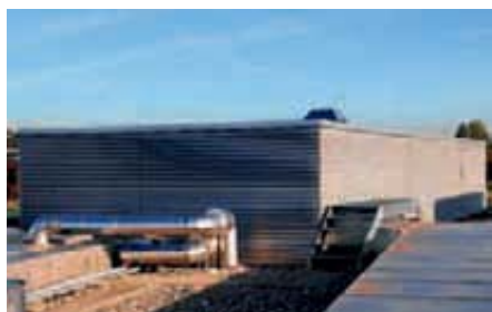
4 – Lamellenverkleidung und Wetterschutz aus Aluminiumlamellen.
