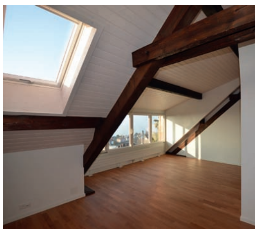
Travaux de menuiserie
