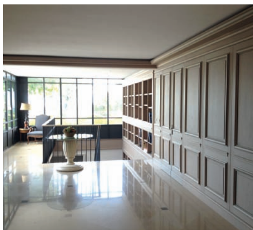
Les parois murales avec portes escamotées
