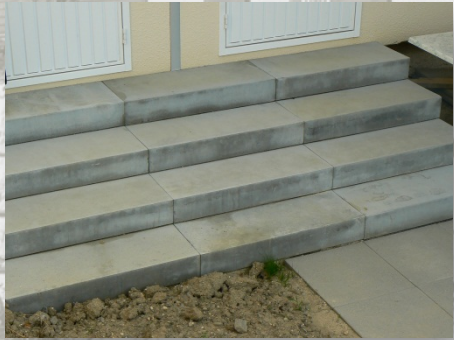
Escalier marche en béton
