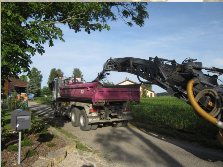
Rabotage de revêtement bitumineux
