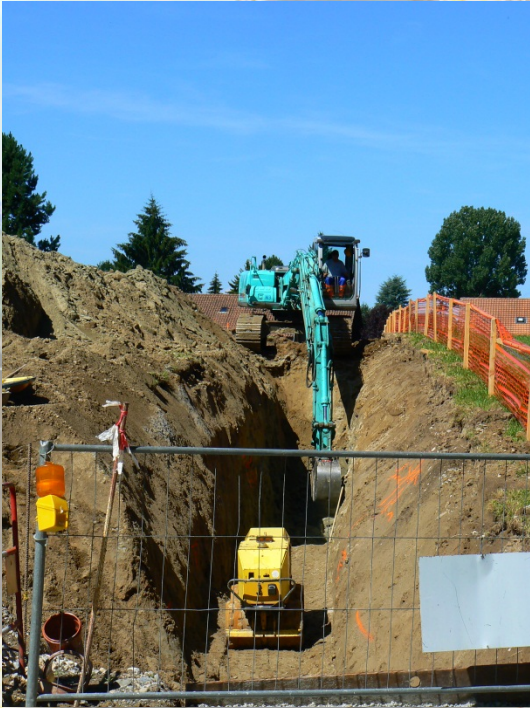
Fouille en tranchée
