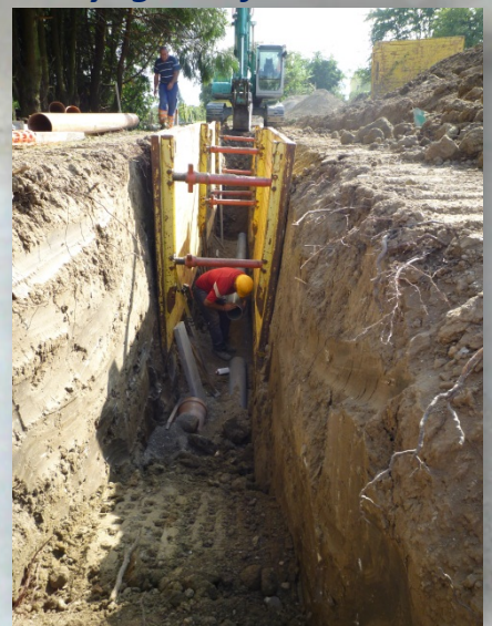
Etayage de fouilles
