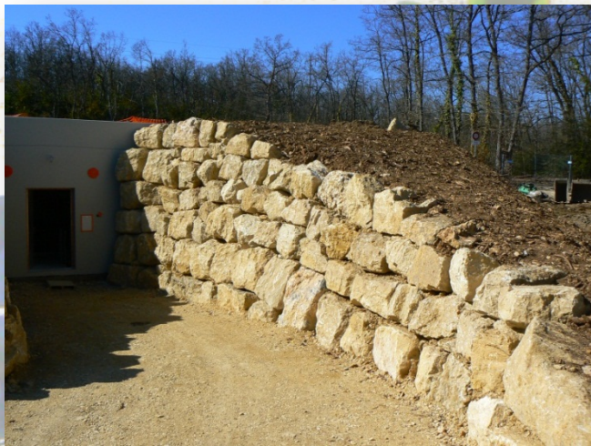
Aménagement de réservoir d'eau
