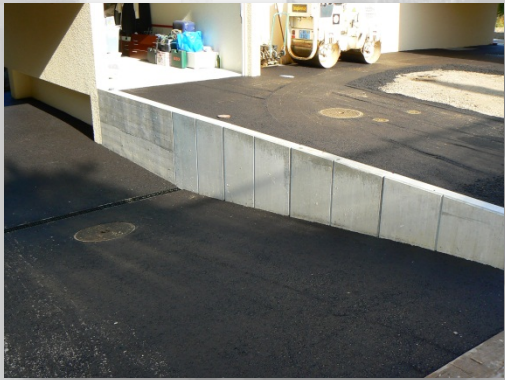
Muret en béton «L» et enrobé
