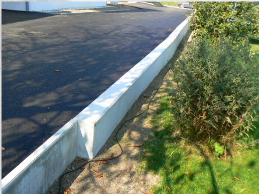
Mini mur en béton
