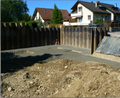
Palplanches et travaux spéciaux
