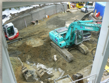
Terrassement et paroi en béton caverneux
