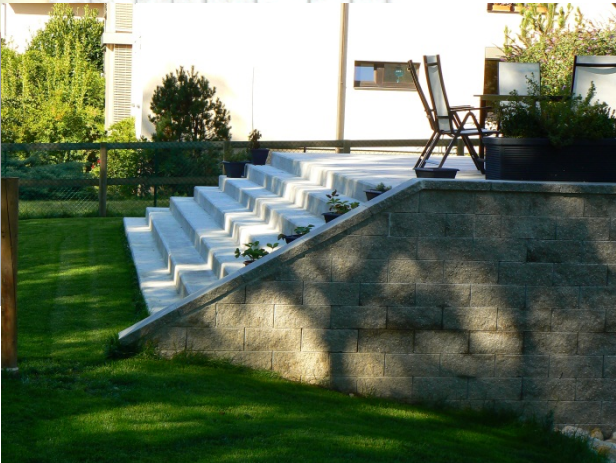
Escaliers et murs
