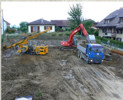
Terrassement et clous
