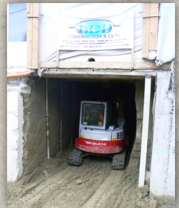
Terrassement de tunnel sous villa
