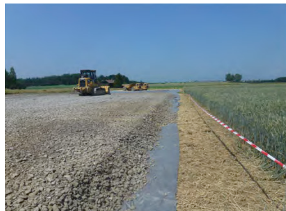
Dépôt de grave sur un geotextile afin de minimiser les compactations du sol en place
