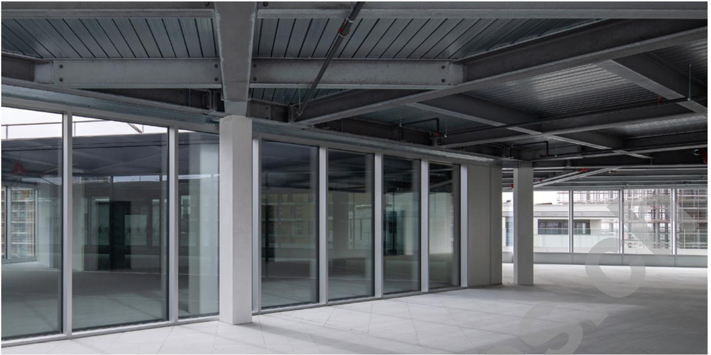
Die Korpuselemente bestehen aus einer dreifachen Innenverglasung, einer integrierten Stoffjalousie und einem nach aussen öffnenden Fensterflügel. Das Gebäude erfüllt den Genfer Standard für sehr hohe Energieeffizienz (THPE). Für die Aussenanlagen wurden Granitsteinplatten verlegt und Bäume gepflanzt, die an die Terrasse im fünften Stock mit einem wunderschönen japanischen Garten erinnern.
