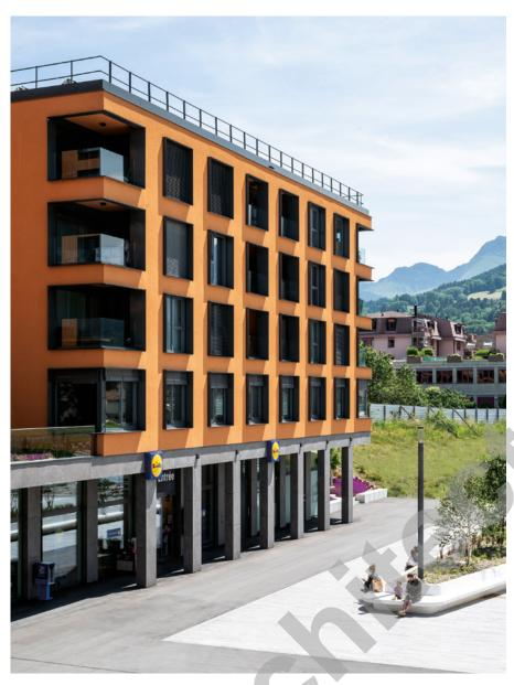
Le projet a utilisé la technologie BIM (Building Information Modeling) pour modéliser toutes les étapes de la construction, depuis les coffrages jusqu'aux armatures. Les bâtiments sont construits en béton armé, avec une superposition de planchers-dalles reposant sur des colonnes et murs porteurs. Les finitions extérieures alternent entre dalles minérales et enduits colorés, tandis que les intérieurs offrent des logements lumineux et fonctionnels avec des matériaux nobles.
