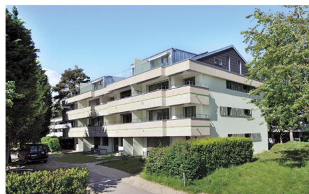
**RÉALISATION** > Après une phase de dépollution des appartements anciens, la mise à niveau des installations sanitaires et électriques ainsi que la pose de triple vitrage renforçant l'isolation assurent un nouveau confort technique et thermique pour les habitants. Le label Minergie® est atteint grâce au travail sur l'enveloppe : laine de roche recouverte de crépi et de panneaux décoratifs en façade et pose de panneaux photovoltaïques intégrés dans les toitures en Eternit.
