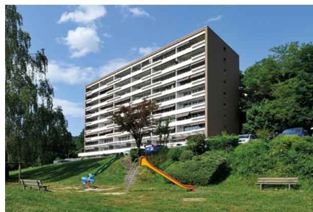
remplacement des stores anciens par des volets roulants dans les chambres, des volets à lamelles sur les pignons latéraux et des stores en toile à projection pour les balcons du côté sud. La nouvelle peinture du soubassement, associée au réaménagement des halls d'entrée et à la transformation de bacs en béton en bancs, achève de donner une touche de fraîcheur au bâtiment.
