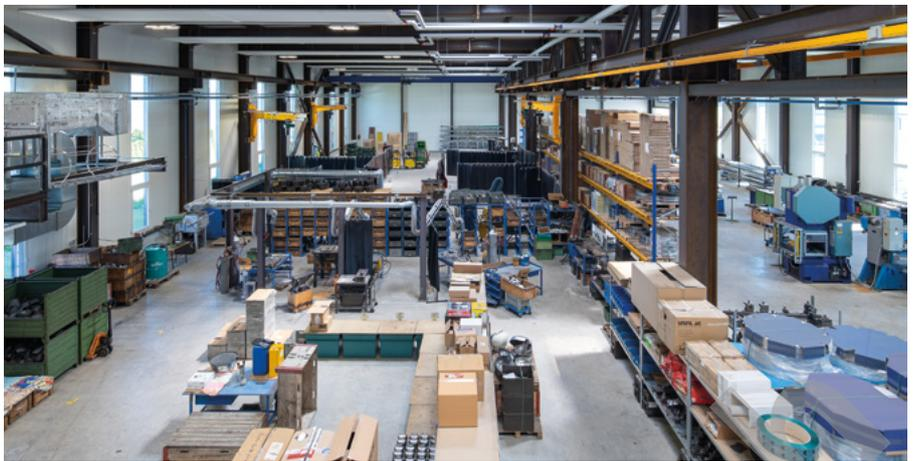
Le bâtiment administratif est en béton armé avec une enveloppe en panneaux sandwich, tandis que la halle présente une charpente métallique. Les espaces intérieurs présentent différents traitements: sol en béton brut taloché à l'hélicoptère dans l'atelier et sol en résine dans la partie administrative ou parquet et moquette dans les bureaux, avec une dominante de teintes grises.
