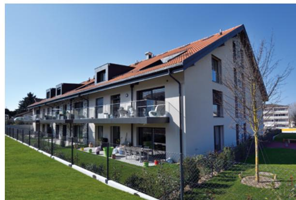
Les garde-corps, en verre transparent, laissent pénétrer un maximum de lumière naturelle dans les pièces de vie. Dans les combles, des balcons baignoires ont été créés dans la pente de la toiture.
