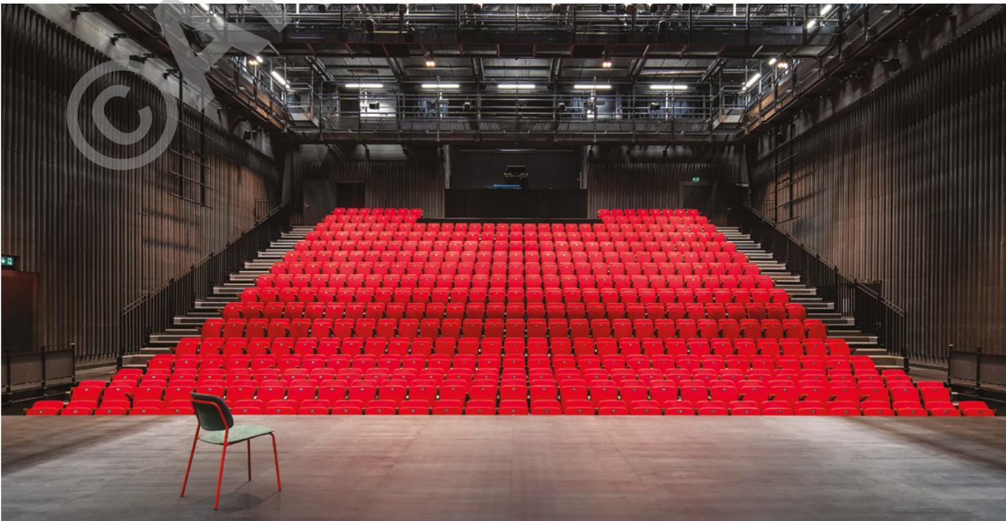
Anforderungen gerecht zu werden. Die Treppe in den Foyers sowie die Dachbinder an der Decke des grossen Saals und die abgehängten Decken in den unteren Foyers sind aus Metall. Den Abschluss des Dachstuhls im zweiten Stock bilden Trapezblechplatten.
