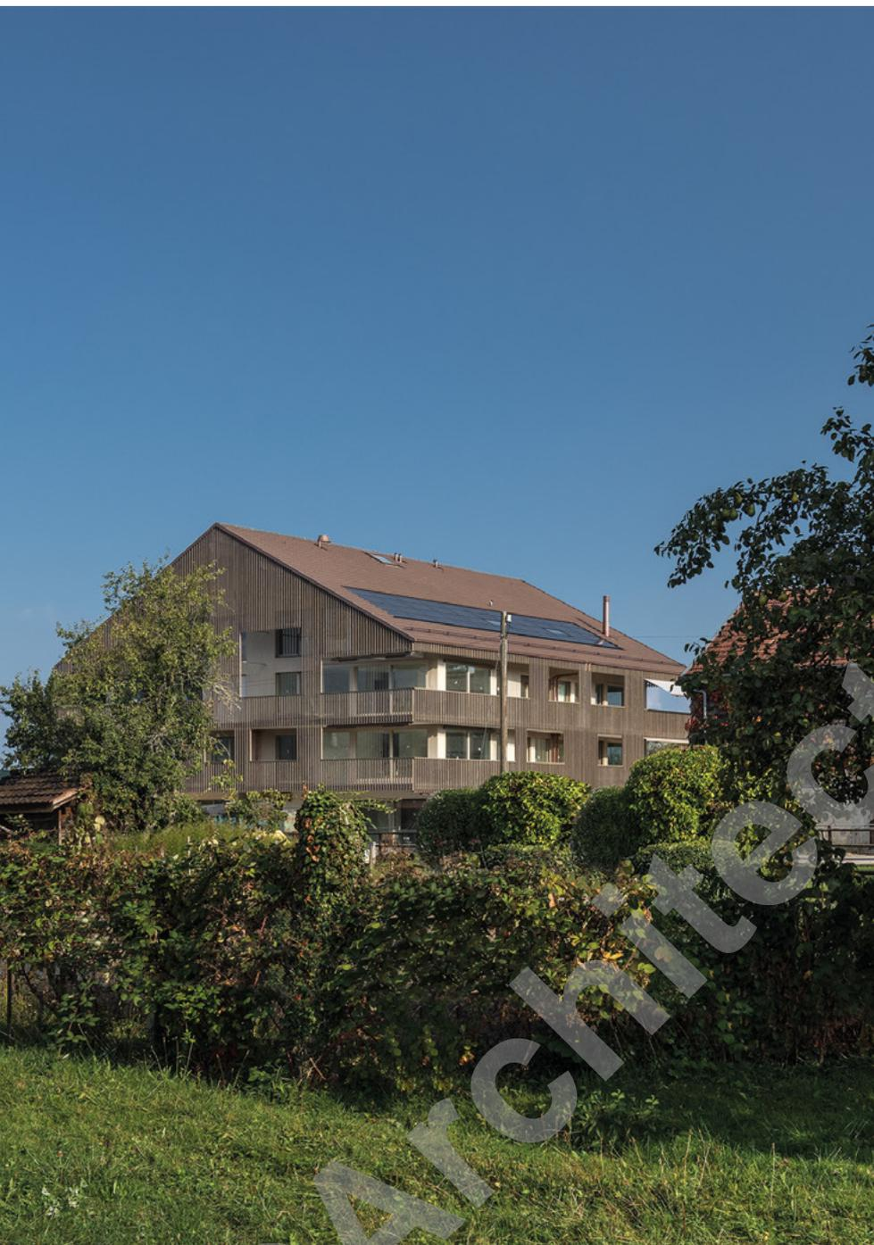
**CONCEPT ÉNERGÉTIQUE** > La nouvelle construction de la rue Essert revendique le label Minergie®. La production de chauffage est assurée par une pompe à chaleur couplée à des sondes géothermiques. Toujours au chapitre développement durable, on signalera la présence de capteurs solaires thermiques et photovoltaïques recouvrant les deux pans de la toiture de ce bâtiment dont les logements sont équipés d'une ventilation double flux et d'un triple vitrage.
