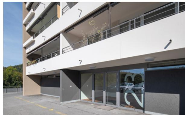
les menuiseries extérieures en bois ont toutes été remplacées par des éléments en PVC avec triple vitrage.
