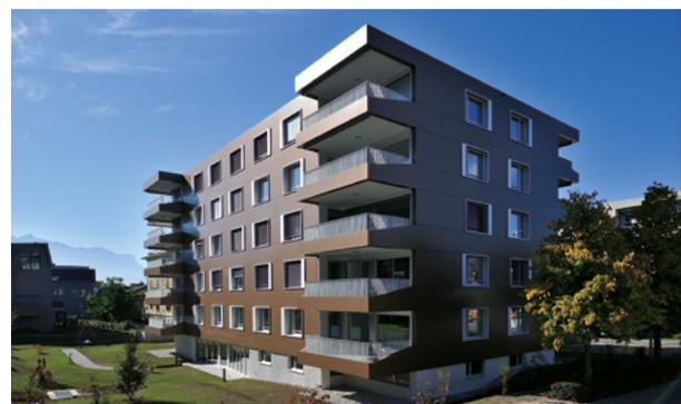
des parapets des balcons. S'affinant vers les extrémités, les parapets pleins, plus intimes, laissent place au barreaudage et à la vue. Les encadrements des fenêtres sont réalisés en aluminium éloxé nature pour contraster avec la couleur brun-cuivré des panneaux composant les façades ventilées.
