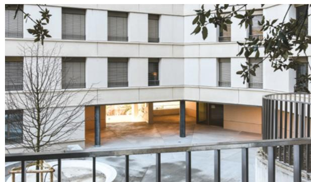
Une alternance de pièces panneaux sandwichs et de bandeaux guident le rythme et le calepinage architectural. Dans les parties communes, les circulations en terrazzo témoignent du soin apporté dans les finitions. Les murs en béton brut de type IV et les garde-corps en inox brossé complètent les choix effectués dans les cages d'escaliers. Les locaux nécessaires au confort des usagers (buanderie, locaux vélos, locaux poussettes, ...) sont présents dans chaque bâtiment.
