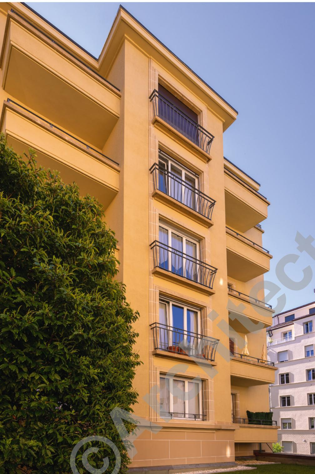
Seuls quelques ouvrants d'origine en bois - belle preuve de longévité - ont été remplacés. À l'intérieur de l'immeuble, les interventions se sont concentrées sur les écoulements, le système électrique et les mesures en cas d'incendie. Les tuyaux d'évacuation des eaux usées et des eaux de vannes (rejet des WC) ont été chemisés. Le système électrique qui comportait encore des fils protégés par du coton a été complètement remis à neuf, tout comme le tableau électrique.
