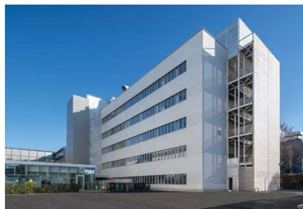
une remise en conformité de la protection incendie des piliers et sommiers. Côté enveloppe, on relèvera l'apparition de nouveaux stores à lamelles motorisés, lesquels sont connectés à la centrale météo. Le bâtiment de stockage a été réalisé en béton, avec prémurs isolés et dalles alvéolaires de grande portée (17 mètres).
