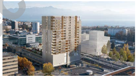
Malley Phare à Prilly est la première tour en structure bois de Suisse romande avec façades actives en photovoltaïque.
