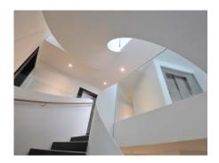
Au système porteur en béton armé répond une façade ventilée en tôle d'aluminium collée (la couleur tire sur le blanc cassé) et une menuiserie en bois-métal. On relèvera, au chapitre des aménagements intérieurs, les garde-corps en tôle d'acier massive pliée de la cage d'escalier. La qualité des finitions des façades et des intérieurs figurait en lettres d'or sur le cahier des charges présenté à l'Entreprise Générale Villvert SA.
