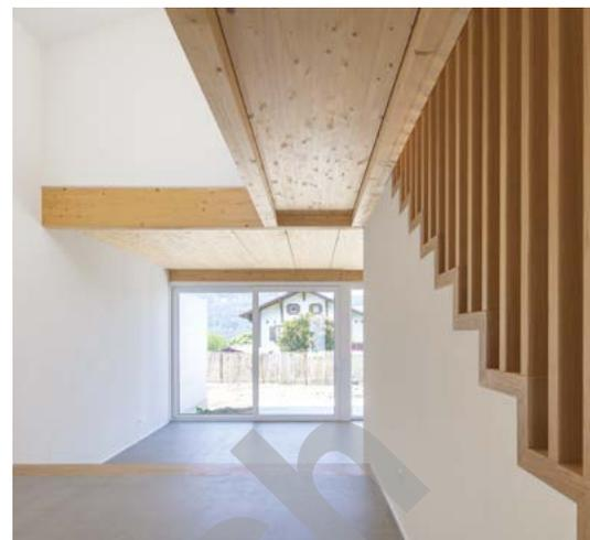
**RÉALISATION** > Les maisons ont été construites en 2018-2019 avec une ossature en bois préfabriqué sur un radier en béton armé. La façade ventilée est composée de lames de bois pré-grisées et de fenêtres à triples vitrages avec cadres en PVC-métal.
