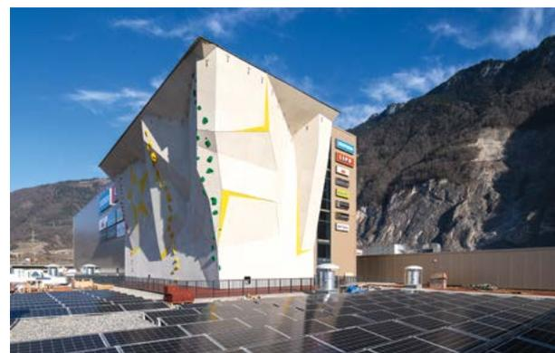
**RÉALISATION** > Le radier a dû faire l'objet d'une reprise intégrale pour le consolider par des micropieux forés sans démolition de la partie basse du bâtiment. Une structure métallique avec des pièces allant jusqu'à 24 mètres de haut a été mise en place. Enfin, une enveloppe de panneaux sandwichs a permis la réalisation dans des délais extrêmement serrés. À l'intérieur, des dalles mixtes ont été posées, laissant la finition des sols au choix des locataires des surfaces commerciales.
