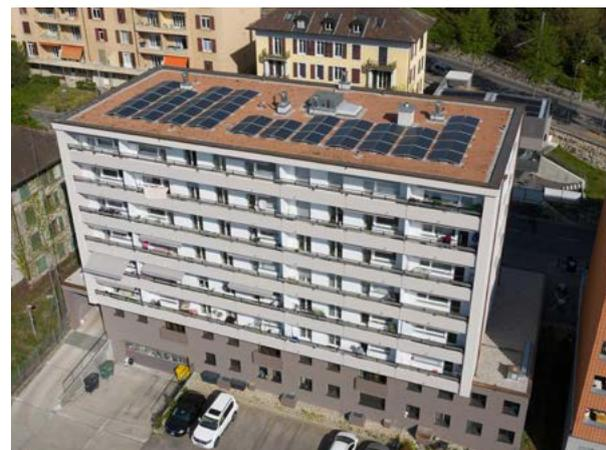
Afin de gagner en efficacité énergétique, les installations des communs sont alimentées en électricité par des panneaux photovoltaïques ajoutés sur la toiture.
