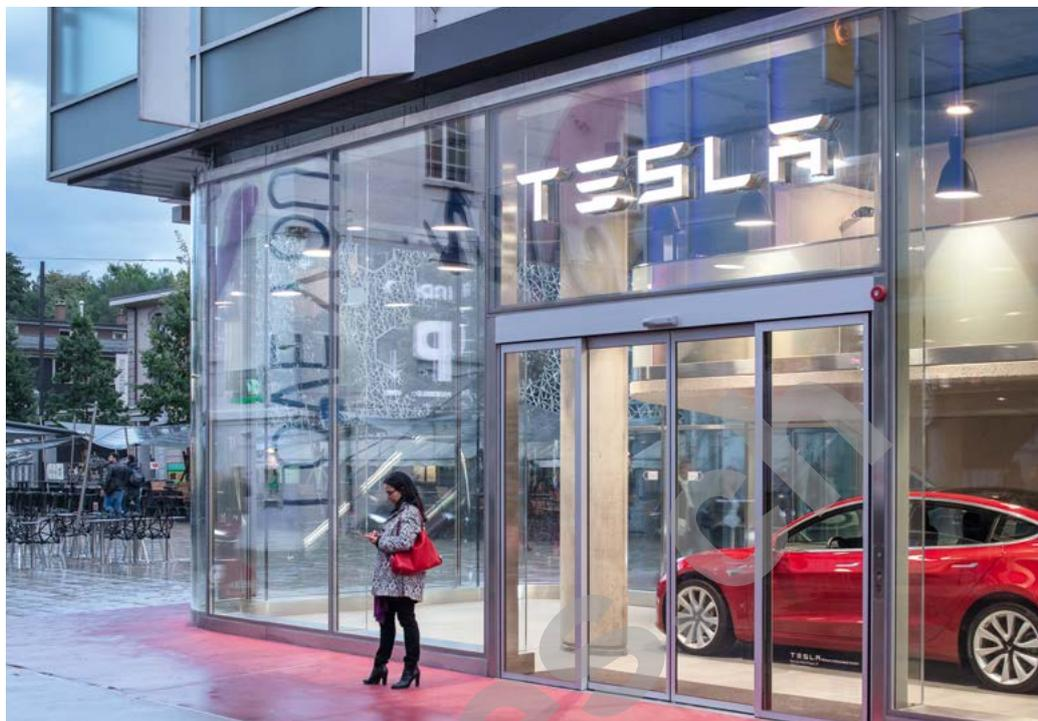
La façade occupant un niveau, d'une hauteur de cinq mètres, est composée de couches de triples verres antireflets courbes et plats. Celle-ci est rigidifiée à l'aide de raidisseurs intérieurs, également vitrés.
