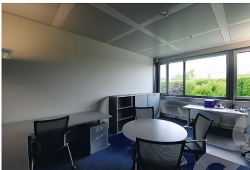
Ce sont les faux-plafonds dits actifs qui assurent le rafraîchissement des locaux. Le chauffage est assuré par des radiateurs placés devant les contre-cœurs des façades. Tempéré par des serpentins alimentés en eau chaude l'hiver et en eau froide l'été, l'air insufflé contribue au bien-être des occupants avant d'être éjecté, filtré et réinséré dans le circuit, selon le principe du double flux à récupération d'énergie.
