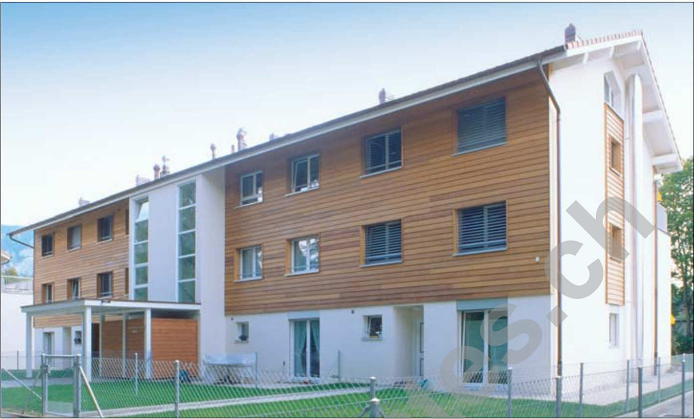
Unité comprenant quatre appartements en duplex sur rez et attiques au 2ème et sous combles.
