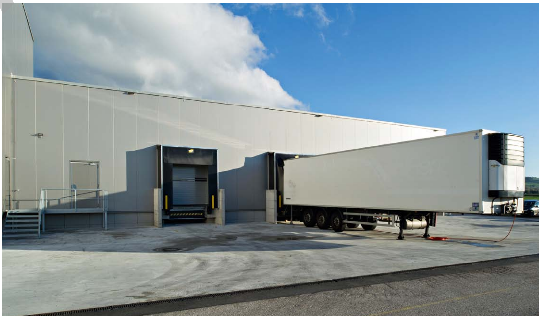
Nouveau quai de livraison
