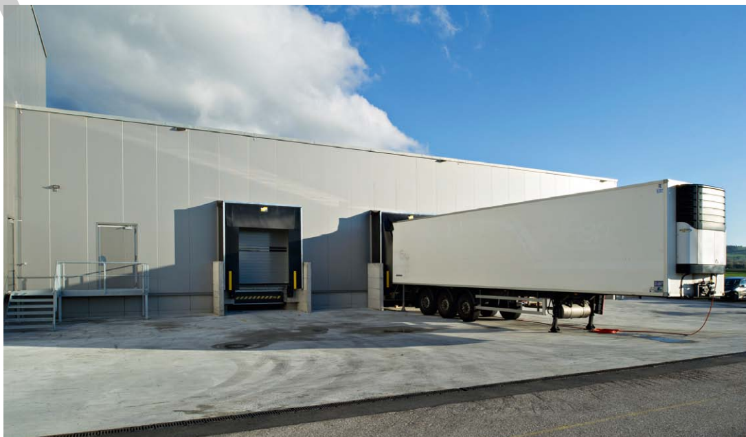
Nouveau quai de livraison
