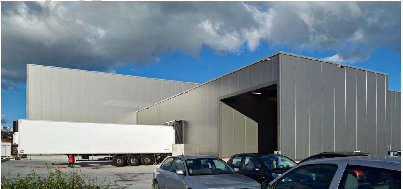
Nouveau quai et halle logistique
