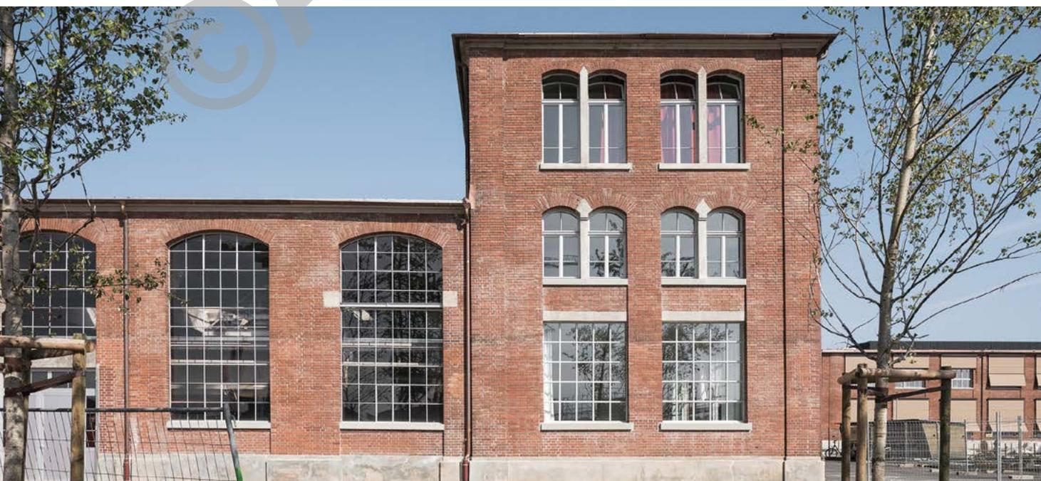
porteuse. La restauration proprement dite, opérée en respectant l'ADN du bâtiment, s'est traduite par une rénovation de la toiture et de la façade. Le mur en briques de la façade Est a nécessité plusieurs phases de lessivages.
