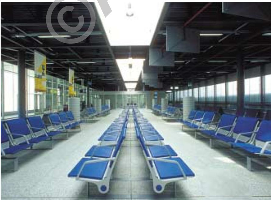
Avec une hauteur statique de 1,60 m, cette construction prend appui sur des piliers métalliques de 400 mm de diamètre disposés sur une trame élargie à 14,40 m de côté. L'ensemble des charges verticales est ainsi transmis au système de fondations pilotées.
