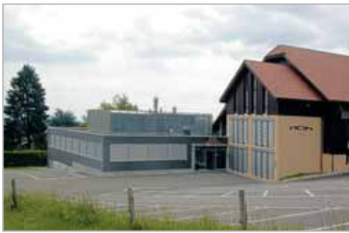
Lien entre l'ancien et le nouveau bâtiment
