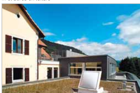
... et aérés en toiture
