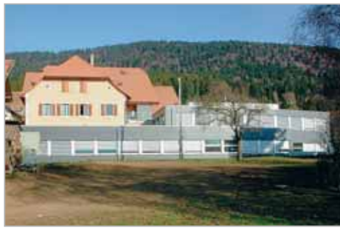
Vue d'ensemble côté Sud
