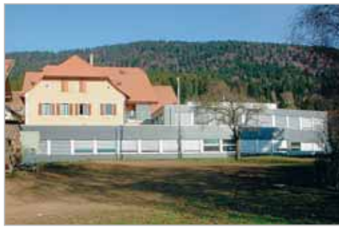
Vue d'ensemble côté Sud
