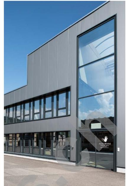
La nouvelle halle a été construite sur le radier des anciens bâtiments qui a pu être conservé. La démolition et la reconstruction se sont faites par étapes, le Maître de l'ouvrage désirant exploiter le site le plus longtemps possible.
