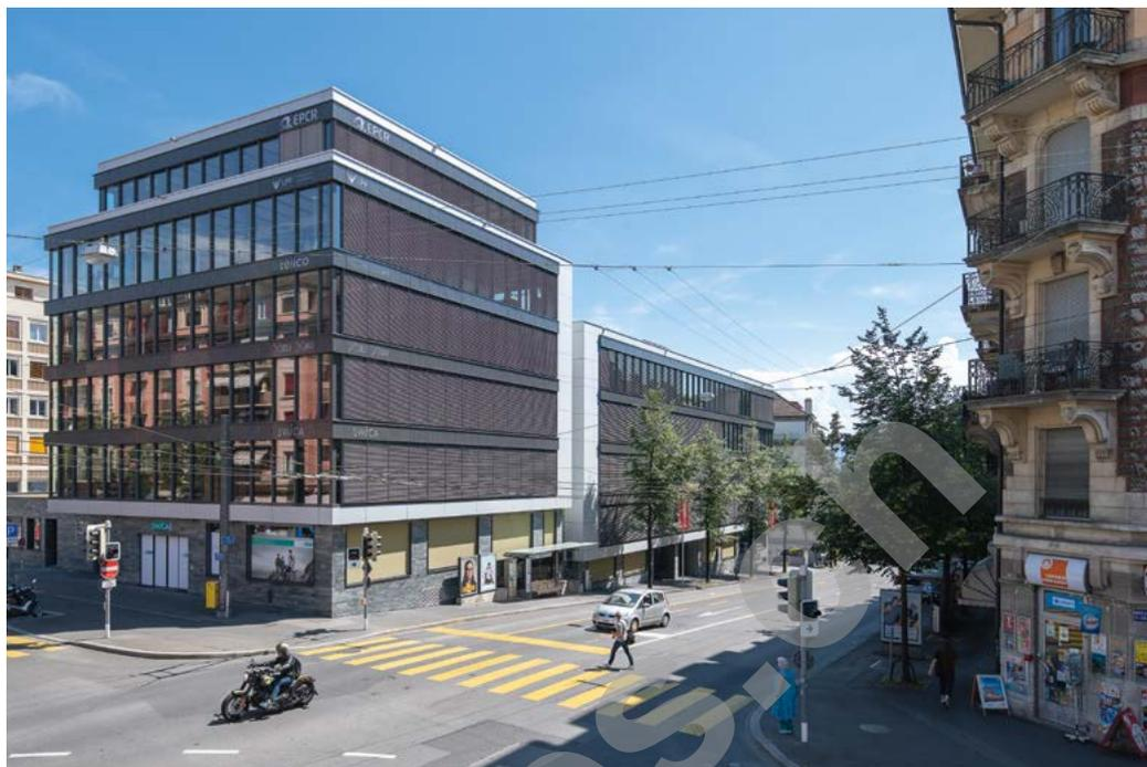
Les façades arborent une dominante anthracite qui s'harmonise avec le gris foncé de la pierre. Mais la cure de revitalisation ne s'est pas limitée à l'enveloppe. Au menu, désamiantage, remplacement des installations CVSE, création d'un plancher technique permettant la distribution des installations électriques au sol et rénovation du parking souterrain. L'implantation des installations techniques a nécessité le décaissement du fond du radier.
