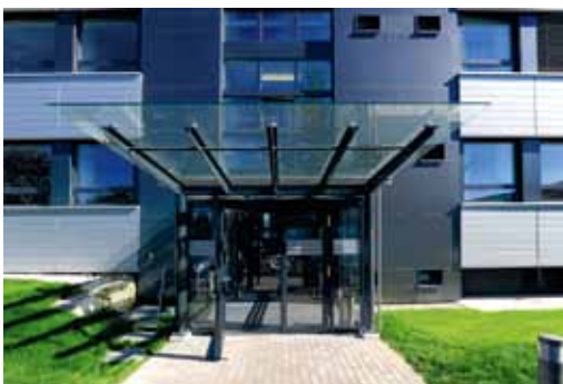
Entrée du personnel
