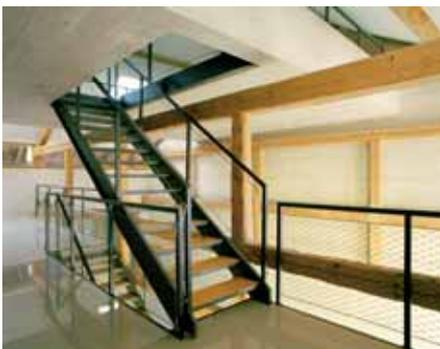
Les circulations verticales ainsi que les balustrades sont réalisées en structure métallique fine. Le cloisonnement des zones sanitaires est réalisé en ossature de bois couverte de panneaux en MDF vernis. Le deuxième point important a été la réalisation d'ouvertures sur l'ensemble de l'enveloppe du bâtiment afin d'amener un apport de lumière maximum, essentiel au travail des artistes.
