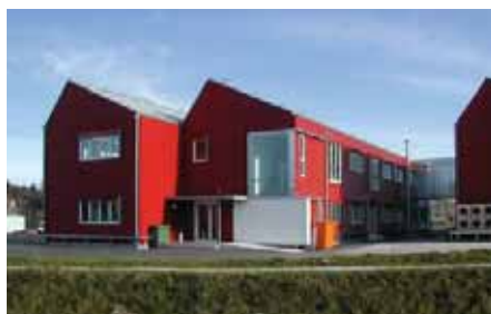
Vue arrière sud-ouest
