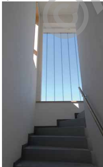
Cage d'escalier sud
