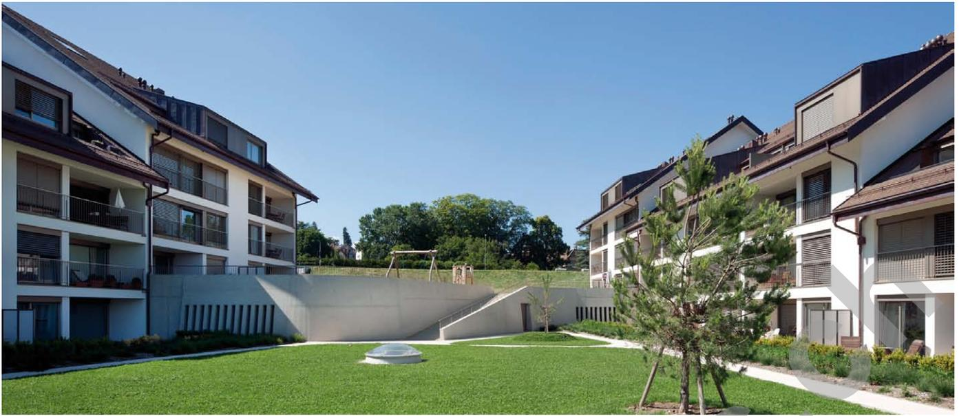
Une isolation périphérique sur structure en béton armé constitue l'essentiel de l'enveloppe, par ailleurs pourvue de quelques sections de façades garnies de panneaux Eternit. A l'intérieur, les sols sont garnis de parquets et les murs sont giclés en blanc, chaque logement bénéficiant de cuisines et salles d'eau complètement équipées, tous les
