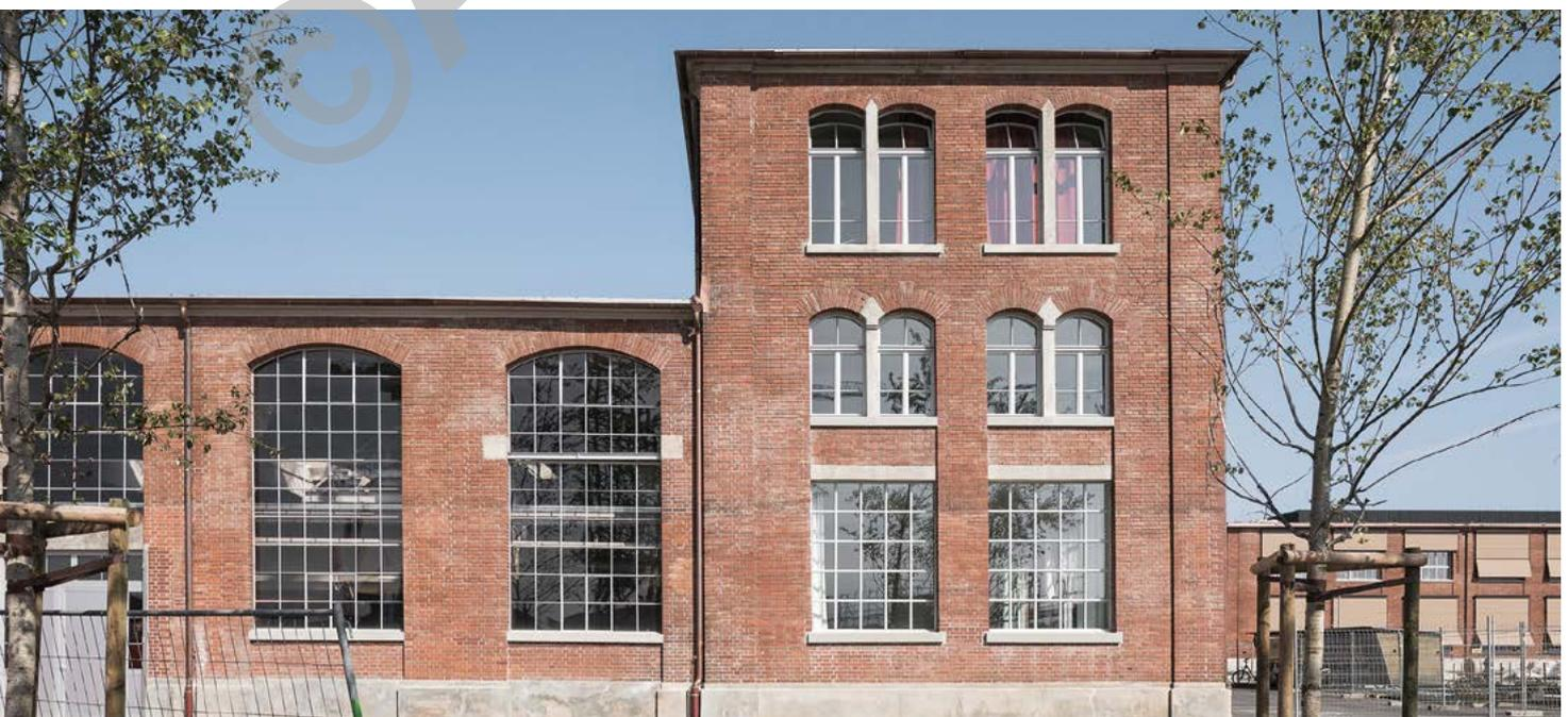
und der Fassade: Das Sichtmauerwerk der Ostfassade musste zur Reinigung mehrmals abgelautet werden.
