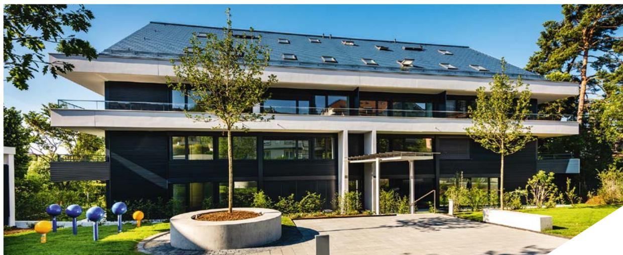
**RÉALISATION** > Sous son grand toit couleur bleue, à double pan et à forte inclinaison, la structure du bâtiment est de facture classique, en béton armé. Les parois extérieures, ventilées, sont doublées d'une isolation périphérique de 20 centimètres et habillée d'une peau lamellée en aluminium thermolaqué de couleur bleue.
