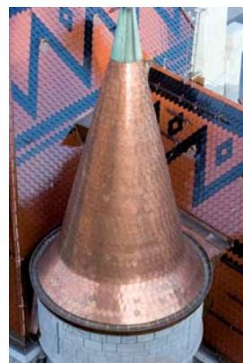
nouvelles exigences de dimension et de confort. En façade, les pierres de taille sont restaurées, les menuiseries remplacées par de nouvelles fenêtres en bois pourvus de verres performants. La couverture est complètement refaite en tuile émaillée sur une charpente d'origine restaurée traitée et isolée. Seule la toiture du donjon reste dans son état initial.
