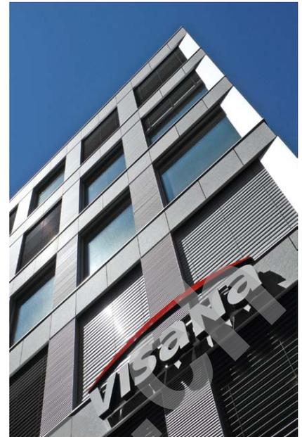
des façades a été réalisé progressivement, par éléments de trois fenêtres. L'intervention s'est faite horizontalement, niveau après niveau.
