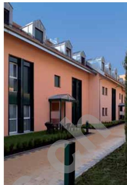
Cette structure, assez travaillée et développée par éléments contigus décalés en plan, prend place sur un socle massif semi-enterré, à l'intérieur duquel se loge le garage souterrain.
