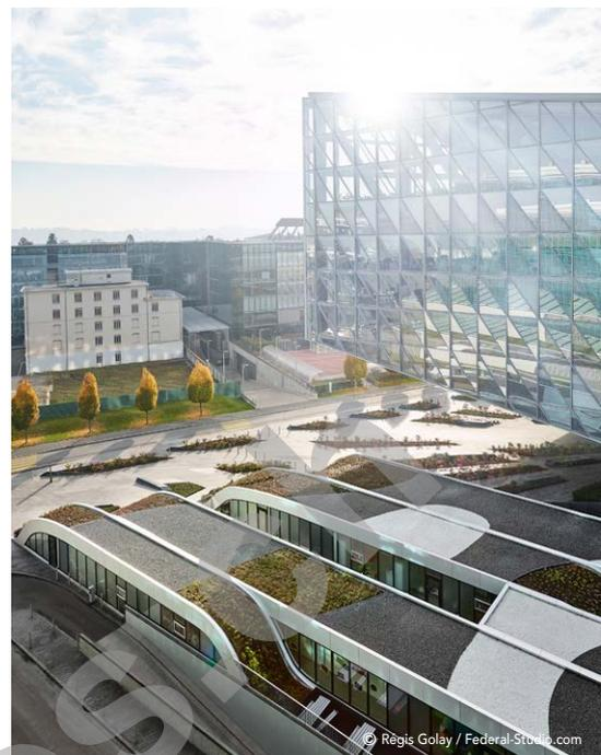
L'implantation habile et la volumétrie rationalisent la surface disponible sans gaspillage. Tout se concentre sur un seul niveau, avec une emprise au sol minimale. Sous un système constructif mixte, dont la structure verticale est en métal et les structures horizontales sont composées en bois, les surfaces intérieures se parent de matériaux simples. Les plafonds sont en plâtre perforé, les murs peints et les sols en linoléum.
