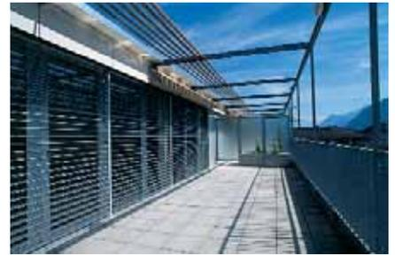
Les façades des volumes d'habitation sont composées de double murs avec porteur intérieur et crépissage sur le doublage externe. Côté voie CFF, une façade métallique ventilée dessine un plan longiligne derrière lequel s'abritent de spacieuses loggias, dotées d'ouvrants multiples. Ce dispositif permet notamment et si désiré, une prise d'air frais indirecte pour les chambres à coucher orientées côté voies, les mettant ainsi à l'abri des nuisances sonores dues au chemin de fer.
