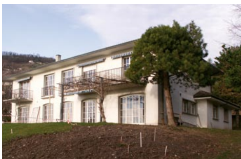
Etat avant travaux
