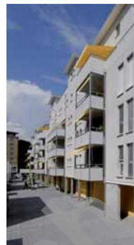
crépi de finition légèrement teinté. Par contre, les rez-de-chaussée sont édifiés en briques monolithes isolantes, garantissant de cette manière une bonne tenue dans le temps de l'ensemble du soubassement. Installations techniques et matériaux de finitions correspondent aux standards appliqués dans ce type de réalisation.
