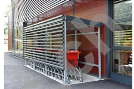
Les éléments rapportés en serrurerie permettent d'alléger la façade en diminuant l'effet de masse.
