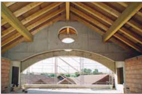
Combles en travaux...
