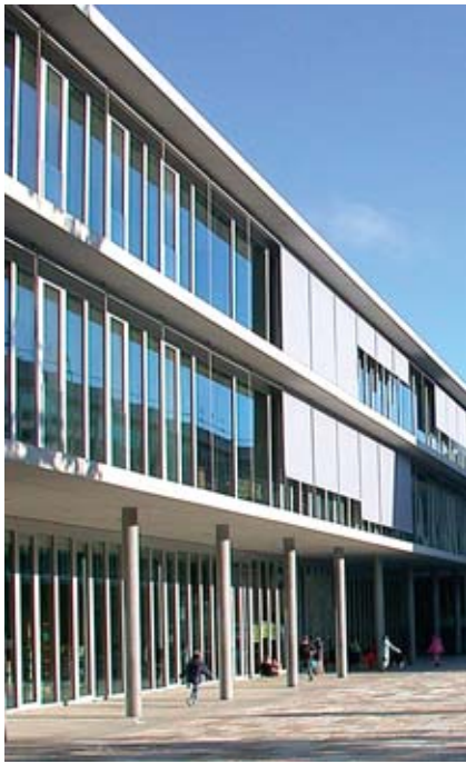
Préau du bâtiment scolaire
